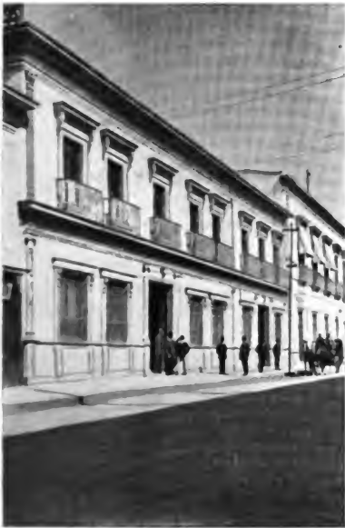
Building of the Banco del Estado de Mexico, Toluca.
